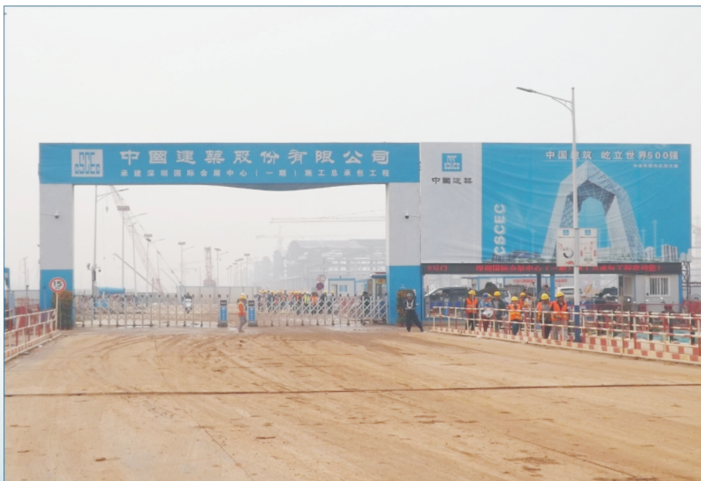
深圳会展中心施工现场
