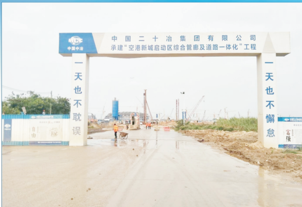
空港新城启动区综合管廊及道路一体化工程
