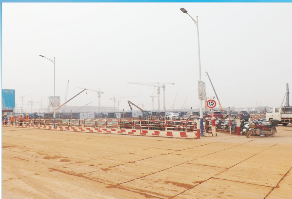
深圳会展中心施工现场
