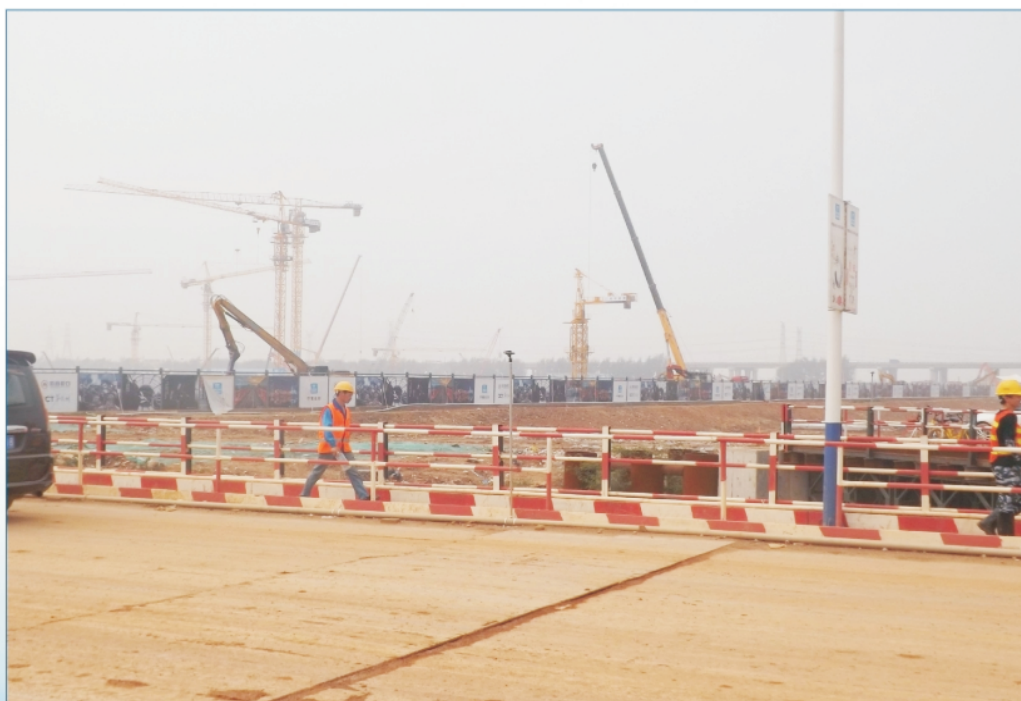
深圳会展中心施工现场
